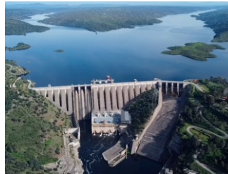
Centrales de hidrobombeo reversibles
